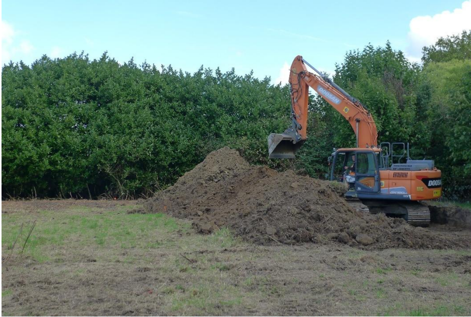
Figuur 3.1 Voorbereidende werkzaamheden project Veldzicht
